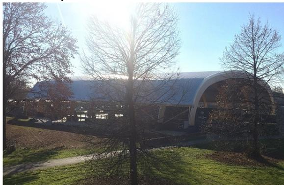
Nell'estate del 2016 - e non nel 1985 - è stata realizzata la mega copertura della piastra da hockey che si trova davanti all'ISIS Marchesini. Una copertura da 500.000 Euro con una struttura portante in legno lamellare aperta sui lati.
